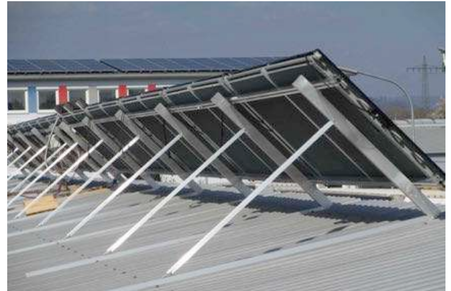
Consolar Gebäude, Lörrach (Vorserie-Montagegestell)
